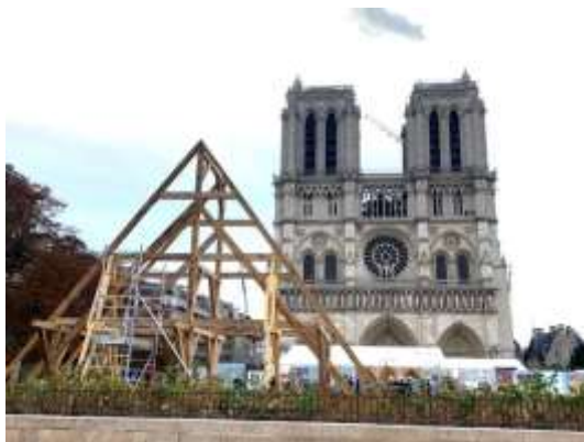
En septembre 2020, lors des journées du patrimoine, la ferme n° 7 reconstituée par l'association « Charpentiers sans frontière » fut dressée sur le parvis de Notre-Dame de Paris
